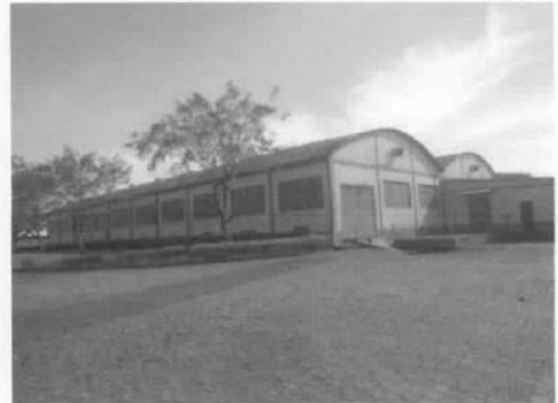
Fachada lateral vista pelo pátio da indústria
