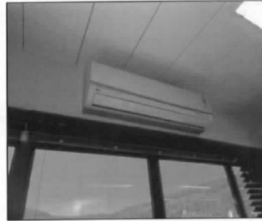
Condicionador de Ar Tipo Split
