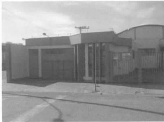
Vista da fachada
