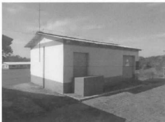
Vista da fachada
