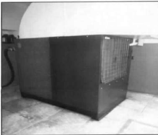
Compressor de Ar Parafuso
